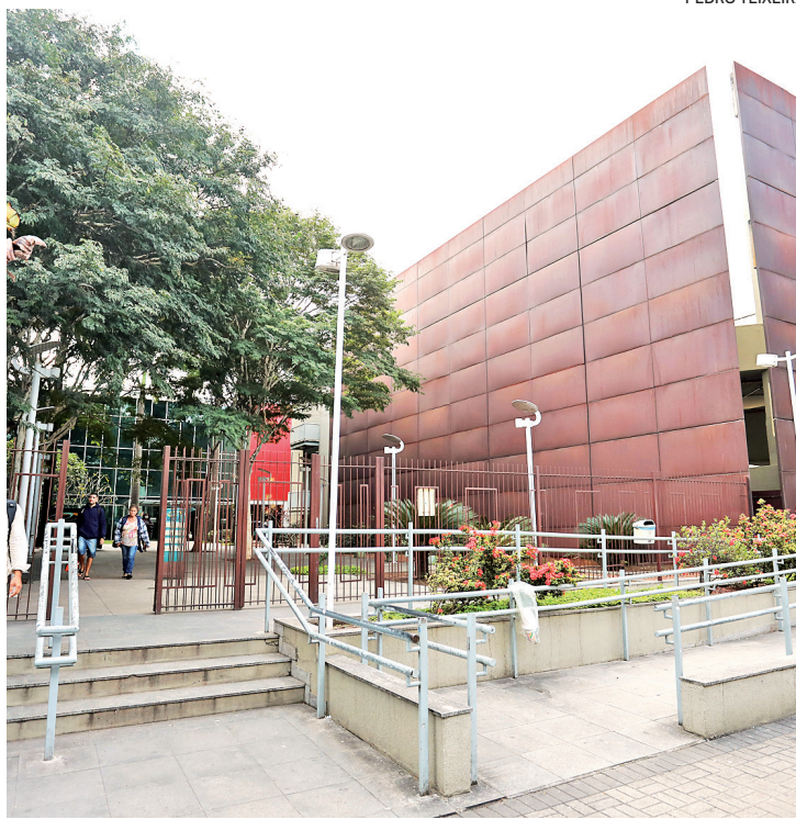
Sede do Into está localizada no Caju, na Zona Portuária do Rio
